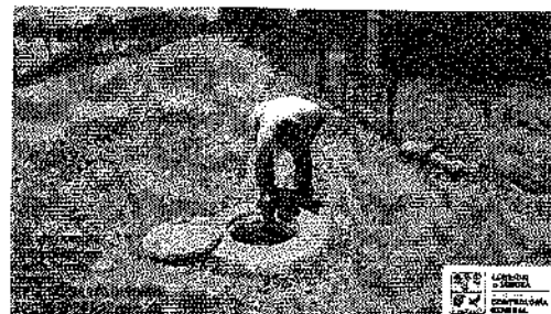
Construcción de pozos de visita, colocación de brocales y profundidades de pozos de visita en la Localidad de Santa Teresa.
