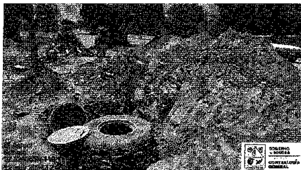
Construcción de pozos de visita y construcción de descargas domiciliarias y registros sanitarios en la Localidad de El Juvani
